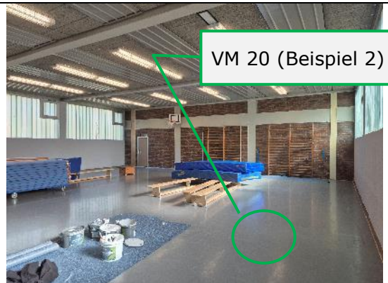
Abbildung 34: VM 20 (Beispiel 2), EG, Hallen, unter Schwingboden, ggf. Abdichtungsbahn oder ähnliches (2 Proben, falls auffälliges Bauteil)
