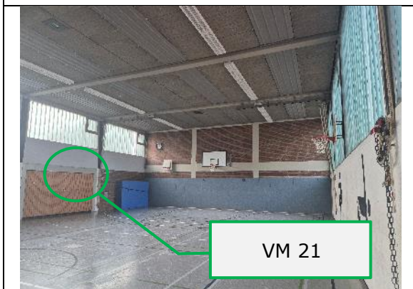
Abbildung 35: VM 21, EG, Hallen, Tor Geräteraum, Zarge, PCB, Schwermetalle (1 PCB-Probe, Schwermetallprobe)
