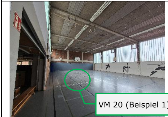
Abbildung 33: VM 20 (Beispiel 1), EG, Hallen, unter Schwingboden, ggf. Abdichtungsbahn oder ähnliches (2 Proben, falls auffälliges Bauteil)
