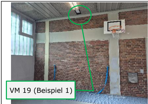
Abbildung 31: VM 19 (Beispiel 1), EG, Hallen, Decke unter Deckenleuchten, Faserplatte (1 Asbestprobe)
